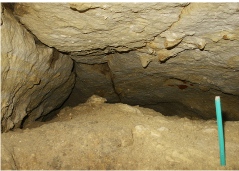
Figura 4.26 - Seção de galeria liberada por colapso da aloalterita, abrindo uma passagem para o fluxo de água concentrada no primocarste da Mansonnière (Normandia, França). © J. Rodet-2001.
