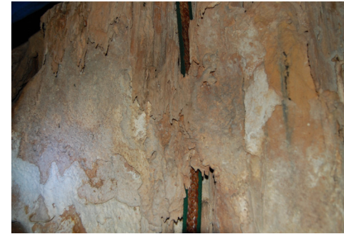
Figura 3.82 - Crosta descolada da parede na qual se apoiava, comprovando a atualidade da alteração das paredes nos condutos da Gruta do Salitre (Diamantina, MG, Brasil). © I. Mascarenhas Oliveira-2011.
