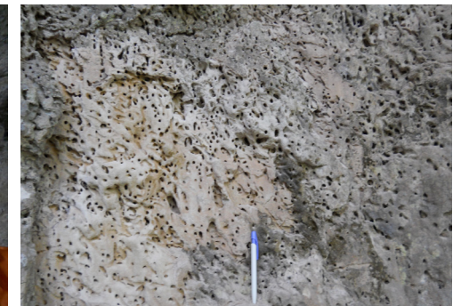
Figura 3.57 - Alvéolos em arenito na parede da Lagoa Azul (Cuiabá, MT, Brasil). © J. Rodet-2010.
