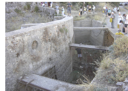
Figura 2.60 - Obras de proteção do katavothre (sumidouro) de Kapsia, um dos maiores ponores dos poljes de Trípoli (Peloponeso, Grécia). © L. Zogbi-2005.
