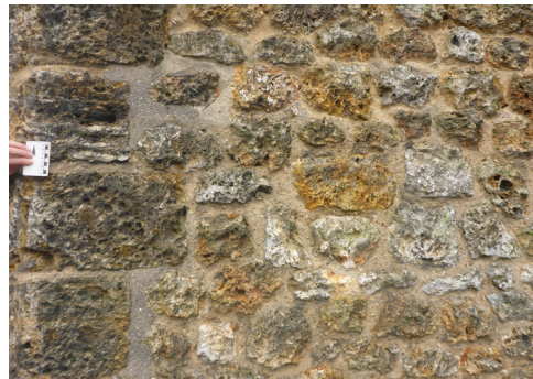
Figure 2.81 - Blocos de meulière utilizados em alvenaria, região de Paris, França. © J. Rodet-2020.
