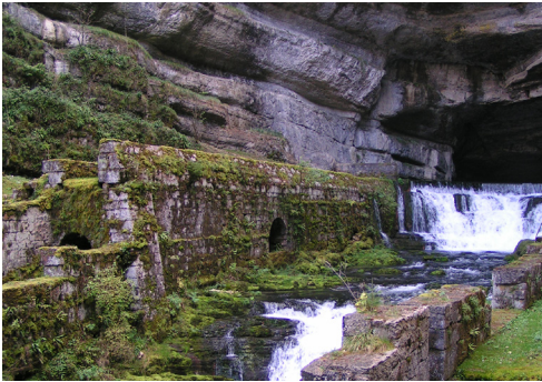
Figure 5.32 - Obra de captação da fonte do Rio Loue (Doubs, França). © R. Hardt-2007.
