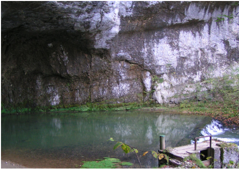
Figure 5.33 - Obra de captação da fonte do Rio Lison (Doubs, França). © R. Hardt-2007.
