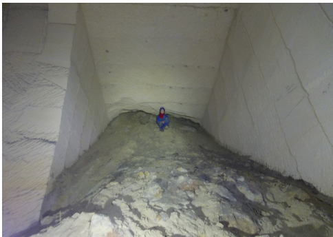
Figura 5.42 - Invasão de galeria de mineração subterrânea por produtos de uma RMA quando de uma trepanação (Montagne Saint-Pierre, Bélgica). © J. Rodet-2013.
