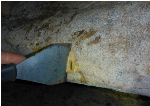
Figura 4.5 - A facilidade com que a espátula penetra no quartzito mostra o avançado estado de alteração das paredes de quartzito da Gruta Monte Cristo (Diamantina, MG, Brasil). © J. Rodet-2017.
