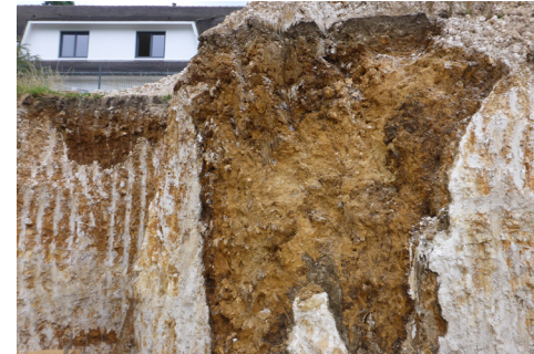
Figura 5.12 - Estrutura da RMA: o centro marrom claro é constituído de loess eólico introduzido pela subsidência da RMA, mais ou menos misturado com a alterita de argila com sílex, enquanto a periferia acinzentada é feita de argila de descalcificação no contato com a rocha encaixante carbonática. © J. Rodet-2016.
