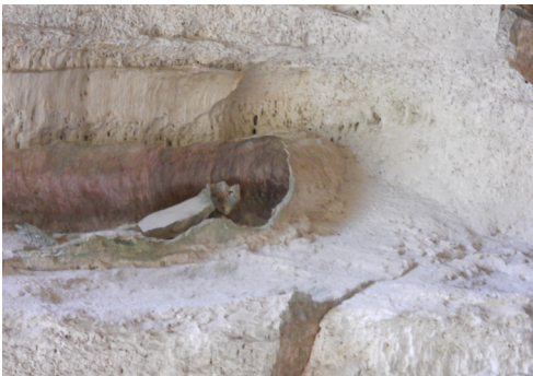
Figura 4.7 - Formação de crosta por exsudação em parede de um conduto cárstico em arenito (diâmetro em torno de 0,80 m), demonstrando a mobilização de sais da rocha encaixante e, portanto, sua alteração em profundidade (Kiogo Brado, Cuiabá, MT, Brasil). © J. Rodet-2010.
