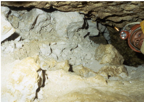
Figura 3.43 - Colapso de uma abóboda obstruindo um conduto no carste de Caumont (Normandia, França). © J. Rodet-1981.
