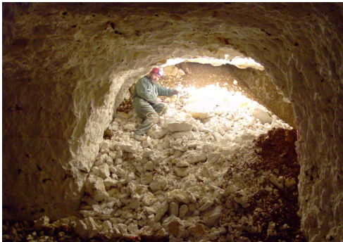
Figura 5.4 - Interseção de uma RMA em marga, desestabilizando a galeria da mina subterrânea (Normandia, França). © J. Rodet-2009.
