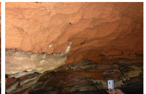
Figura 3.87 - Crosta no arenito em processo de destruição, testemunho de uma alteração generalizada no teto e nas paredes da cavidade (Serra de Itaqueri, SP, Brasil). © J. Rodet-2017.
