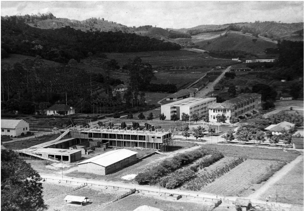
CEE - Construção e expansão
