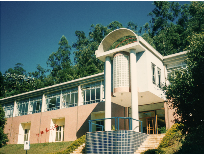
Fachada do Departamento de Arquitetura
