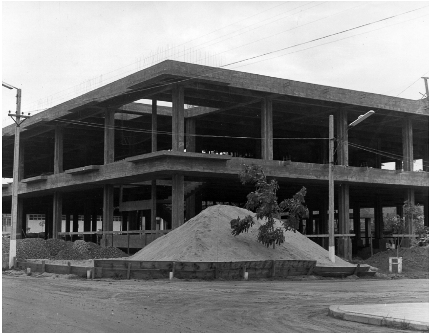
Prédio da Biblioteca Central em construção
