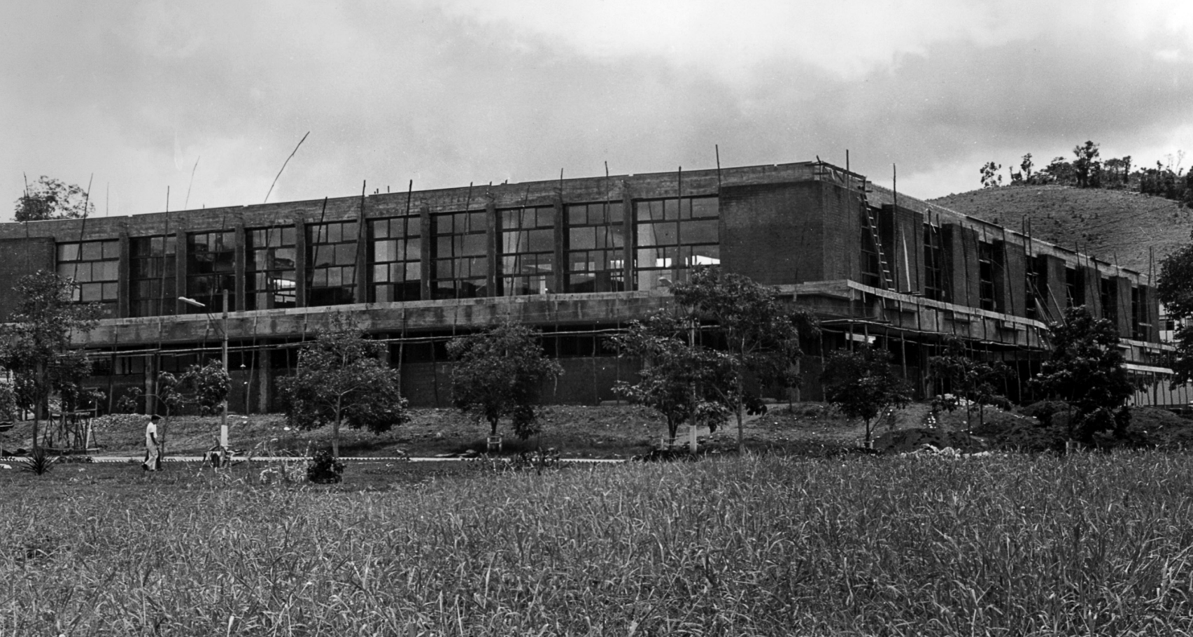
Etapa final da construção da Biblioteca Central
