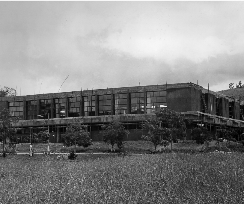
Biblioteca Central, prédio com primeiro pavimento concluído
