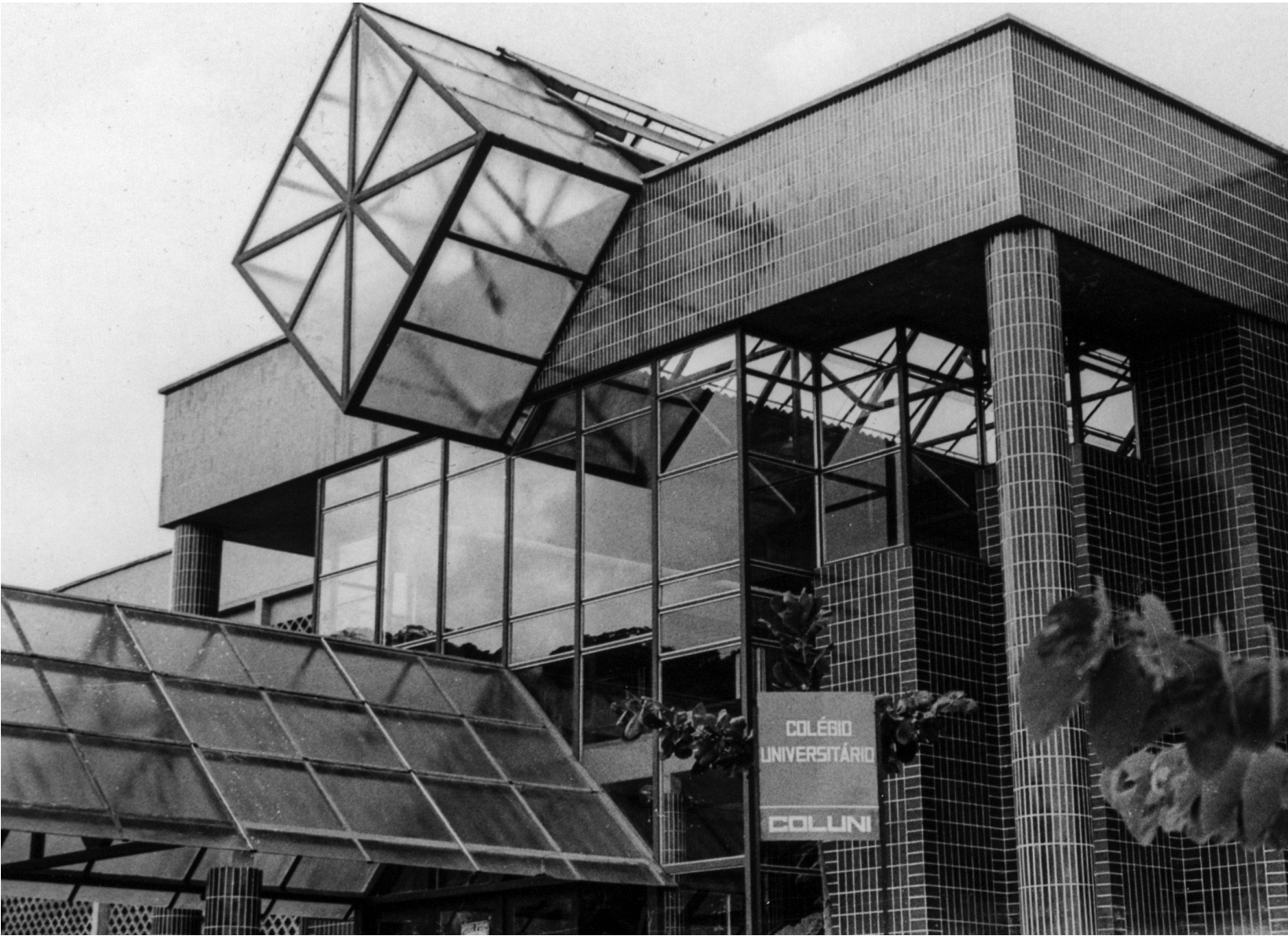
Fachada parcial do CAP-Coluni
