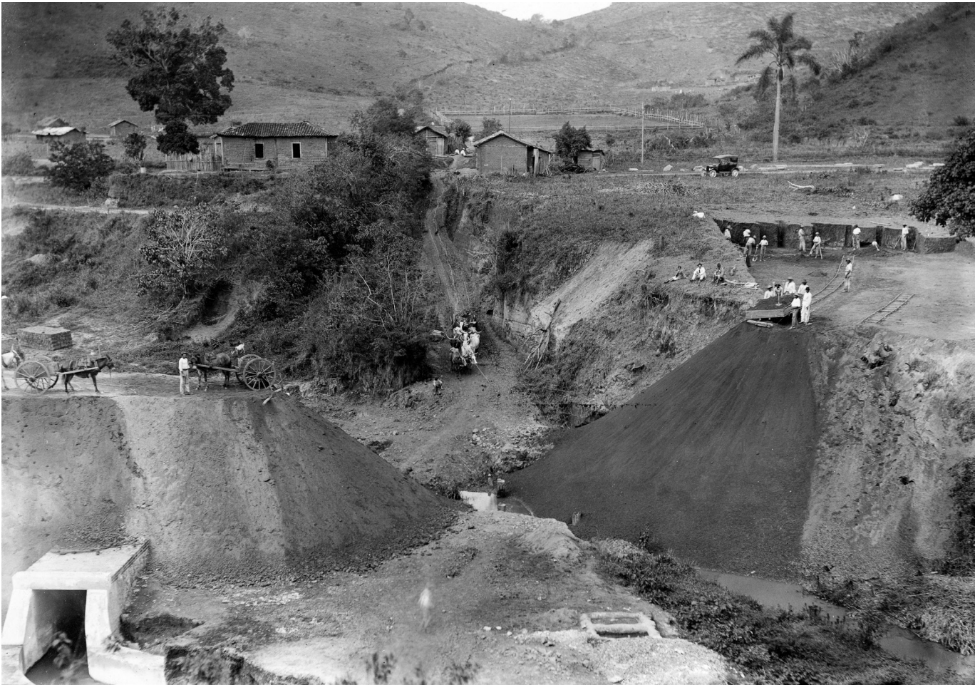
Fotografia tirada no “pé” do morro dos Operários. Nota-se, à esquerda, o bueiro do Ribeirão São Bartolomeu em funcionamento e, no detalhe, a utilização de bovinos e muarés no aterramento. À direita, a futura localização das Quatro Pilastras
